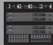
Bühnen-Rack mit 24 Eingängen und 8 Ausgängen
